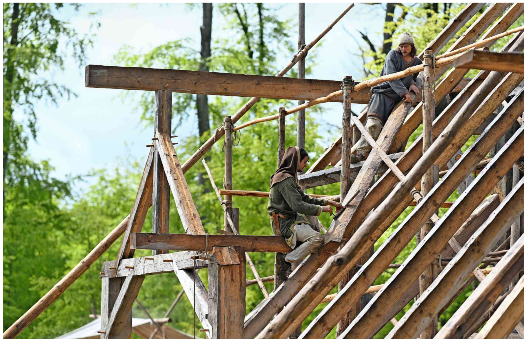
Altbewährtes für heute: Im schwäbischen Meßkirch arbeiten Zimmerleute mit gut abgelagertem Holz und traditionellen Techniken an einer mittelalterlichen Klosterstadt Foto dpa
