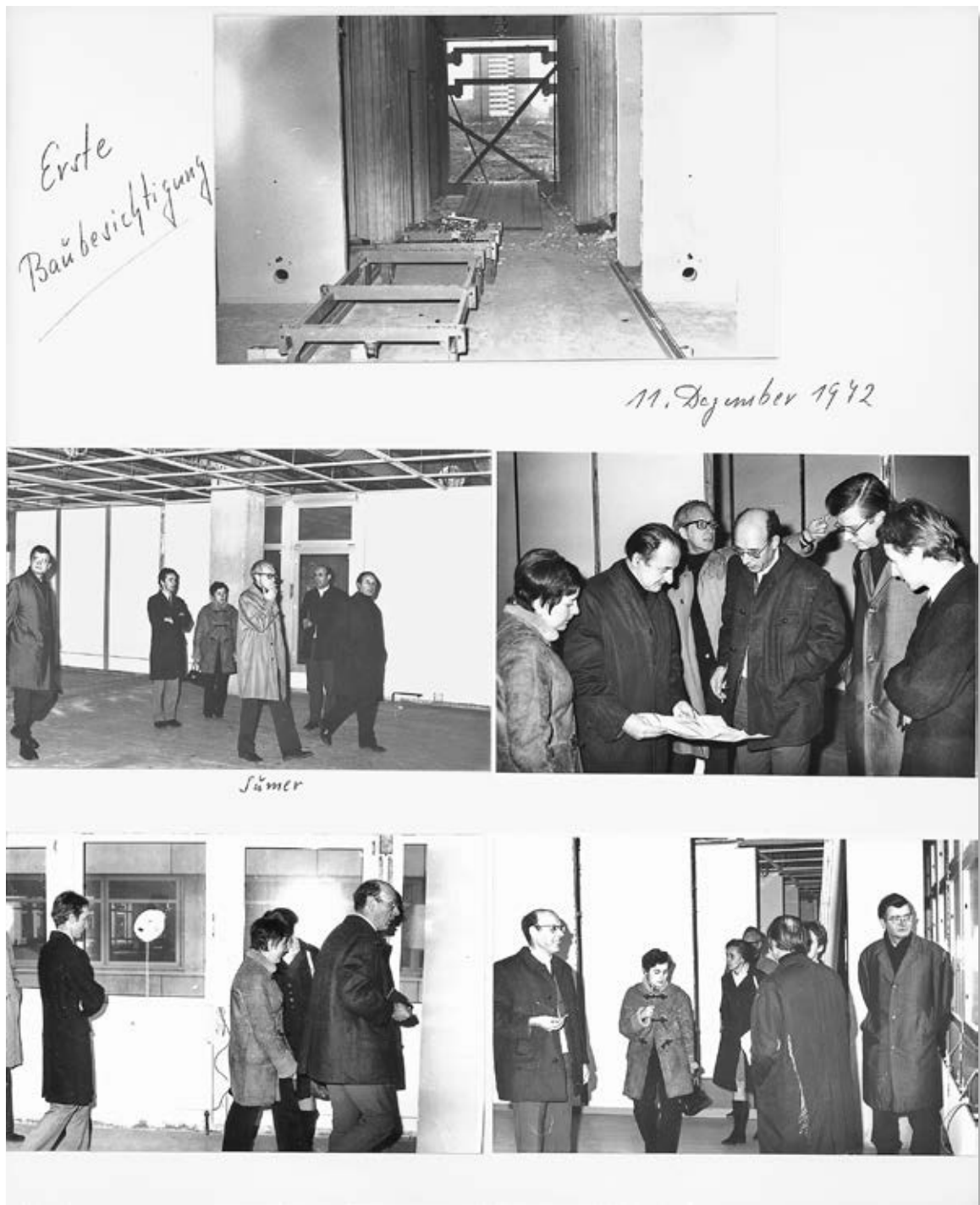
BESICHTIGUNG DES ROHBAUS IM NEUENHEIMER FELD 305, FOTOGRAFIERT VON LOTHAR BAUR, © IGEN
